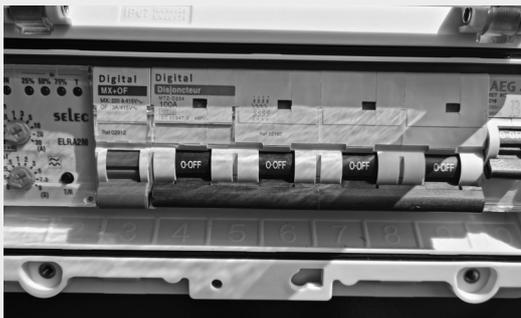
Contrôler que le disjoncteur principal soit en position off (bas). Brancher la fiche mâle CE 400V dans la prise femelle, puis actionner la palette du disjoncteur vers le haut (on). Votre PTO devient
